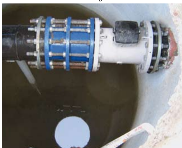
Debitmetru și senzori de sens, montați pe conductele de alimentare cu apă potabilă
