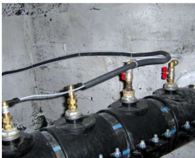
Debitmetru și senzori de sens, montați pe conductele de alimentare cu apă potabilă
