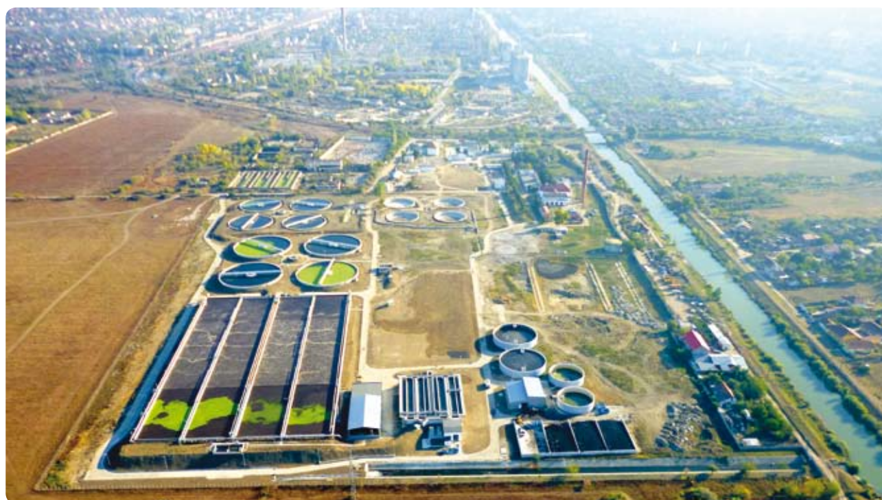
Vedere aeriană a stației de epurare din Timișoara
