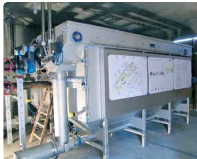
Schimbătoarele de căldură, care preiau căldura din apa uzată
