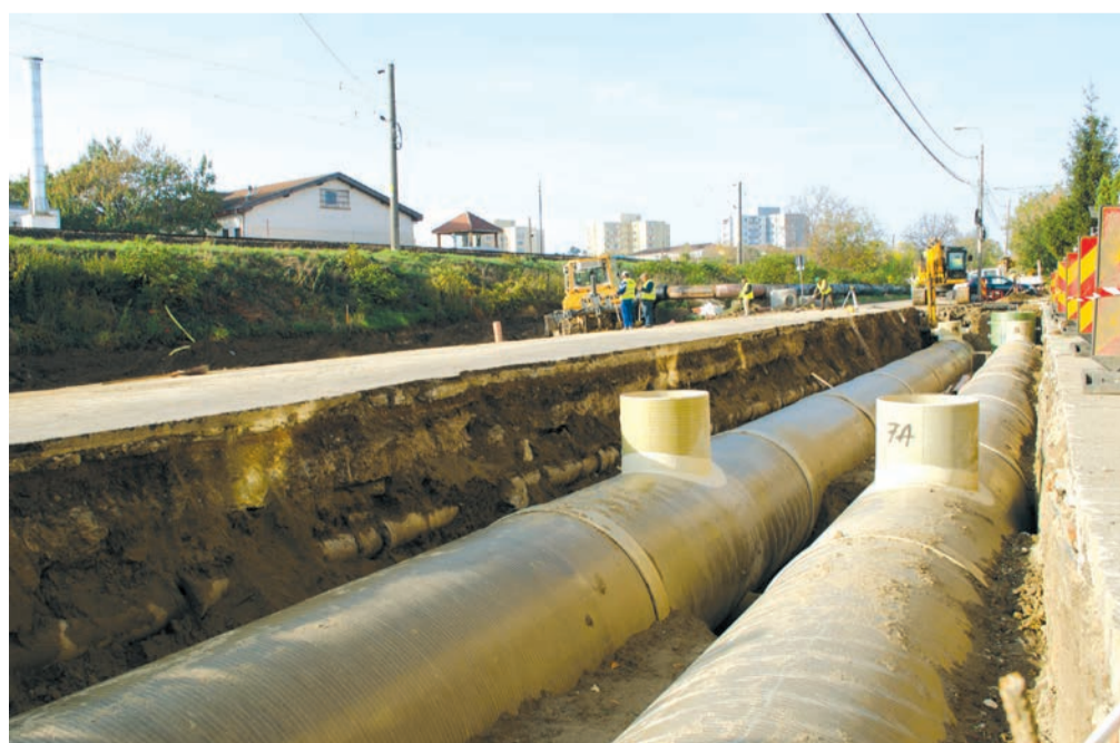
Bazin de retenție a apelor pluviale, cu eliberare controlată în canalizare, în zona pasajului Popa Șapcă. Foto: Aquatim
